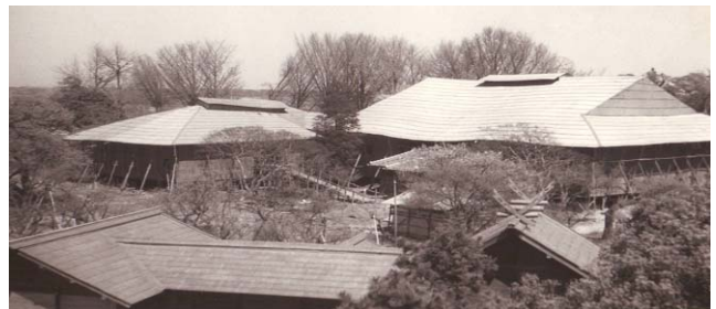
図2-25：昭和の修理工事の様子（正庁・至善堂：昭和38年竣工）（弘道館事務所所蔵）
